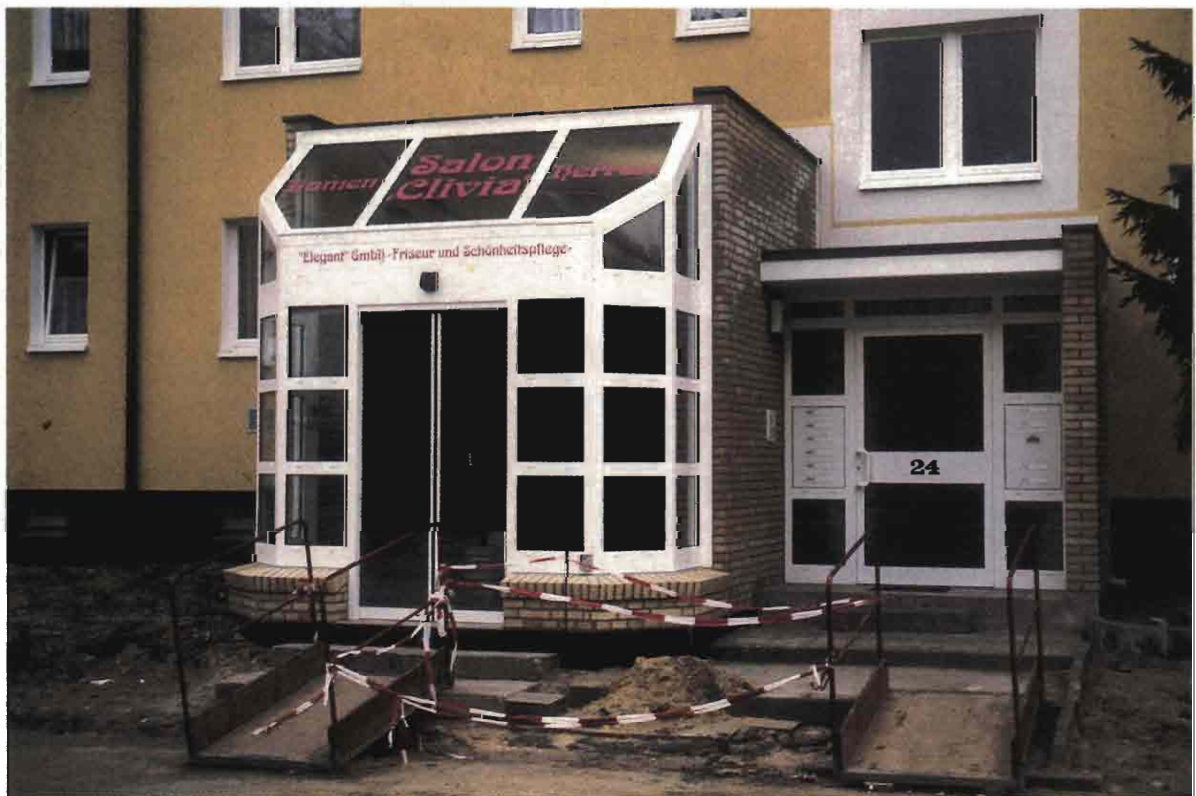
Zusätzliches Wärmedämmsystem, neuer Hauseingang und ein kleiner Friseursalon im Erdgeschoß
