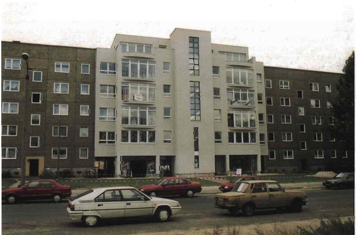
Wohn- und Geschäftshaus als Lückenschließung
