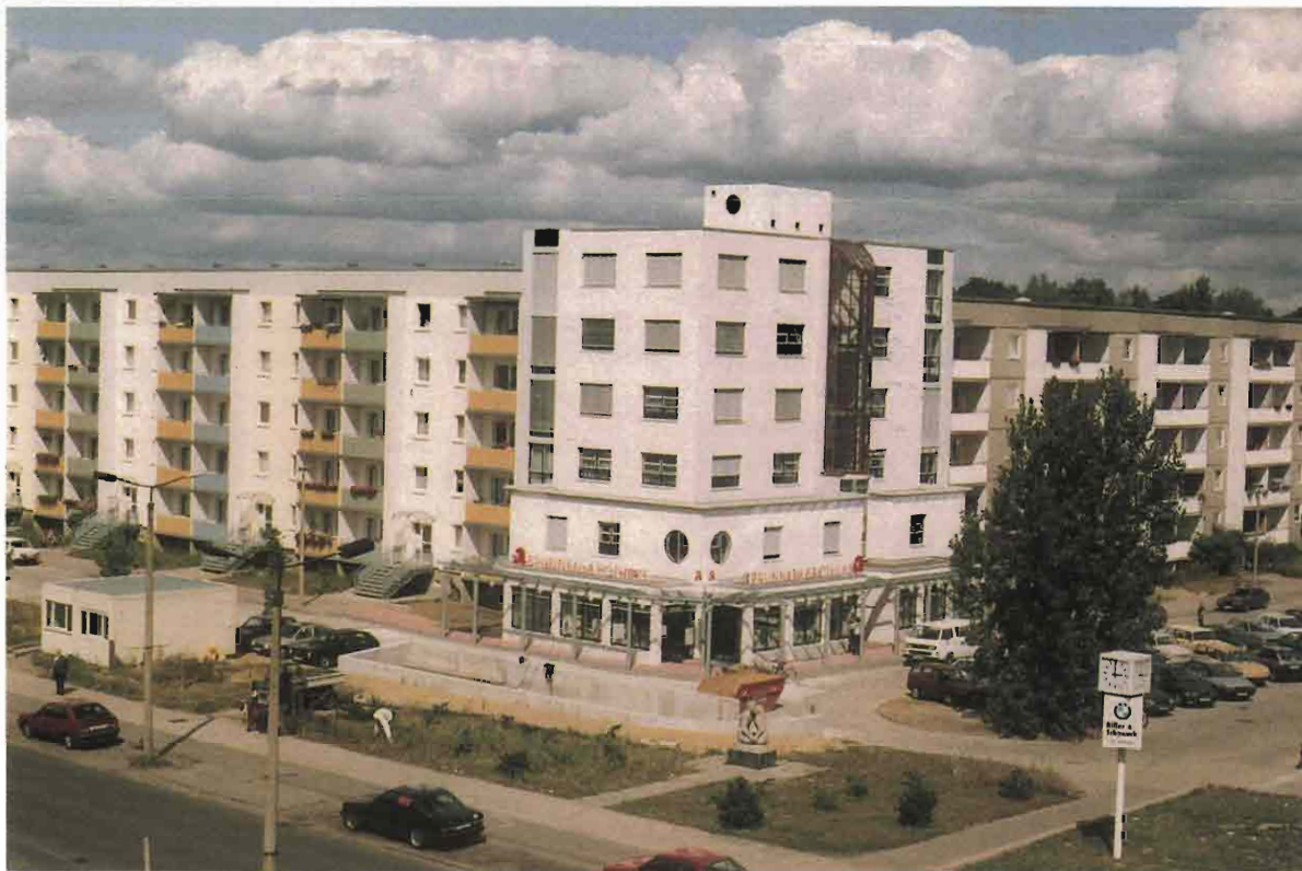
Stand nach Fertigstellung August 1993
