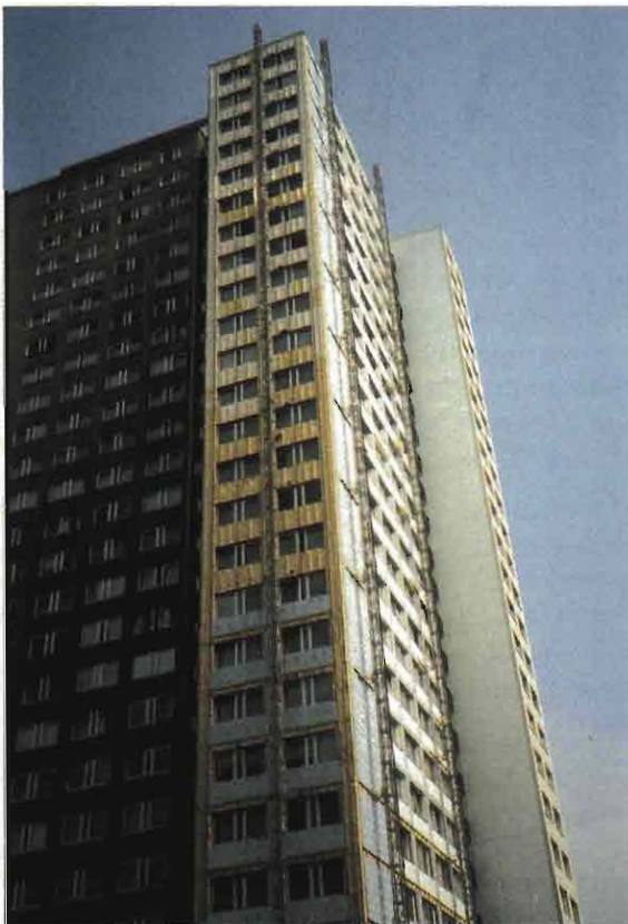
Zusätzliches Wärmedämmsystem auf der Plattenfassade
